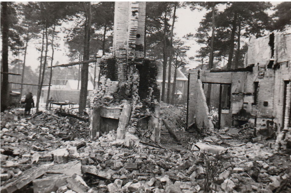
Johan van Limbeecklaan 9 en 11; aan de schade is goed te zien dat de Dornier nummer 9 als eerste vol trof, bijna alles is weggevaagd, behalve de stevige, dikke scheidsmuur. Op nummer 11, waar de familie Van Doorn woonde, staat nog een deel van de buitenmuren overeind. Niet zichtbaar op de foto's, maar de scheidsmuur stond tot en met de top van de schoorsteen overeind. Bron: P.H. van der Meer
